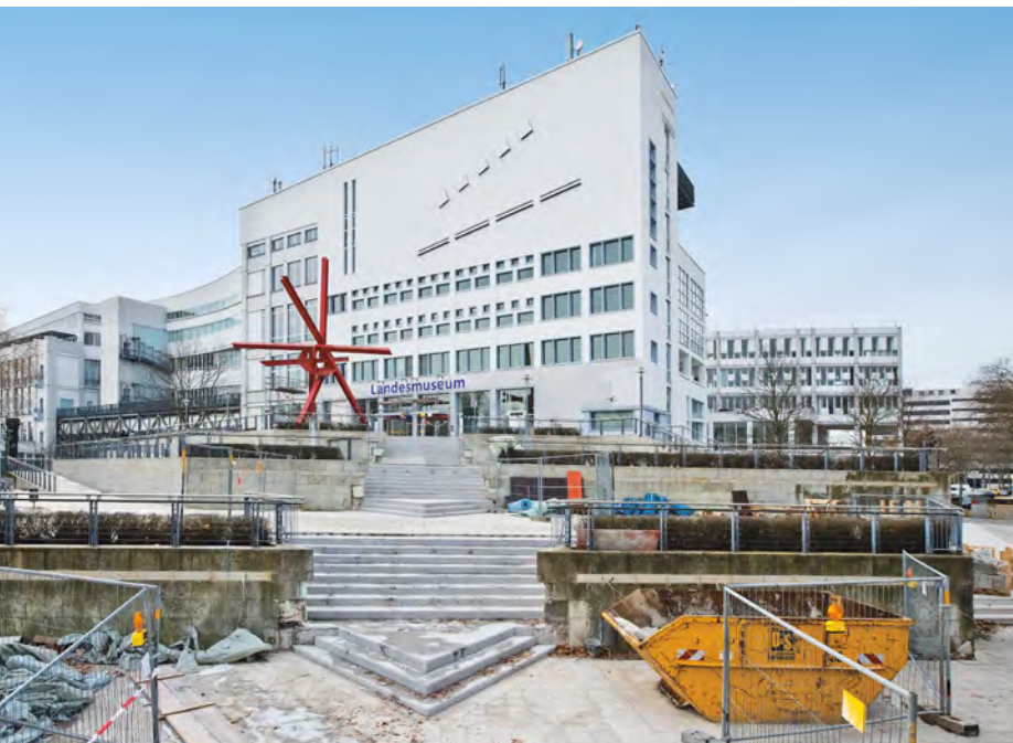
Umfassende Betonsanierung an der Treppenanlage des Technoseums in Mannheim
