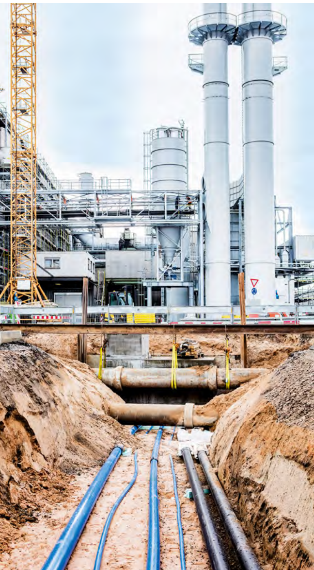
Leitungsbau für Daimler in Mannheim
