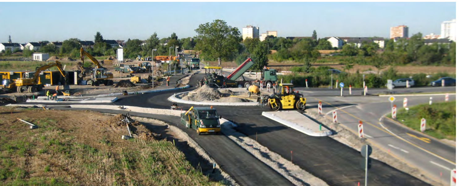
Erschließung eines Gewerbegebiets in Schwetzingen-Nord
