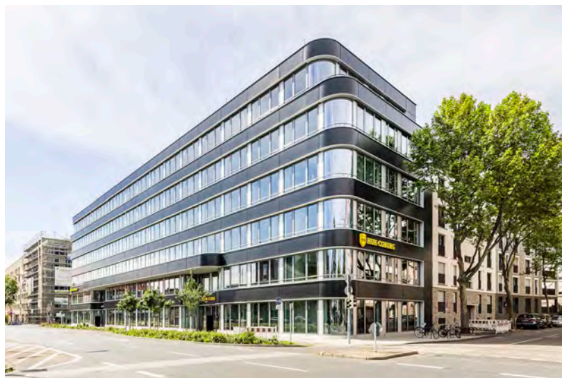
Das Kepler Quartier im April 2019 – D&S hat ab der Projektentwicklungsphase einen Start-Up-Prozess implementiert um alle Prozesse im Leistungszyklus der Immobilie zu koordinieren.
