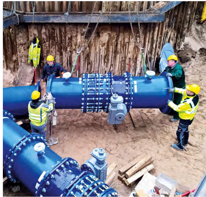
Wasserleitungsbau: MVV, Wasserwerk Mannheim-Rheinau
