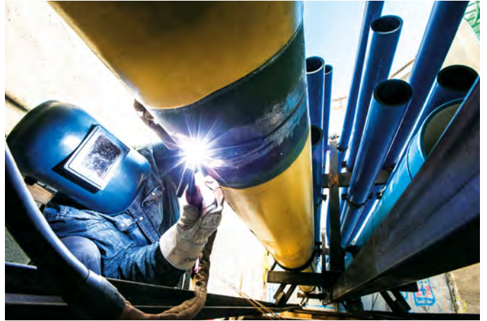
Schweißarbeiten an einer Gashochdruckleitung
