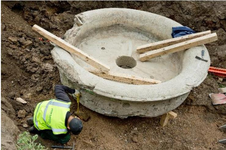
Doku / B9: Die Unterfangung wird notwendig, damit im Anschluss die Stahlträger unter dem Becken unterlegt werden können, die zur Verschwenkung der „Seerosenschale“ mittels Autokran benötigt wurden.
