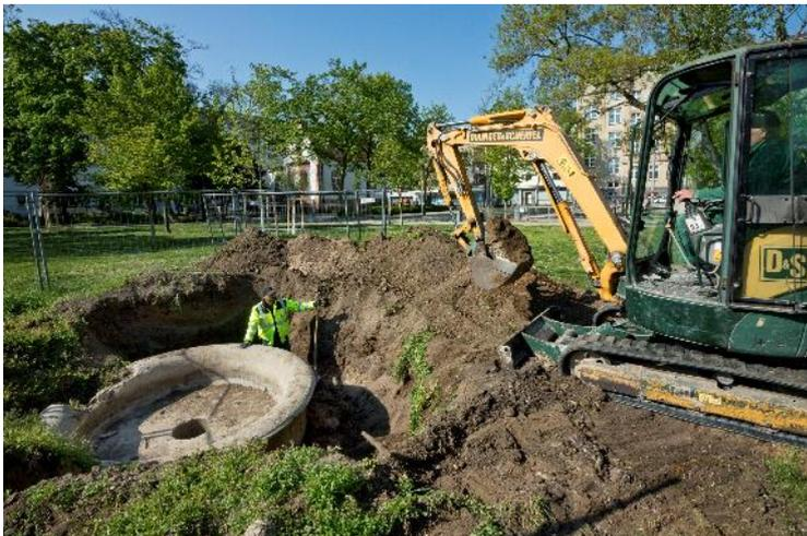
Doku / B6: Mit Bagger und Schaufel wurde die Seerosenschale Meter für Meter vorsichtig freigelegt
