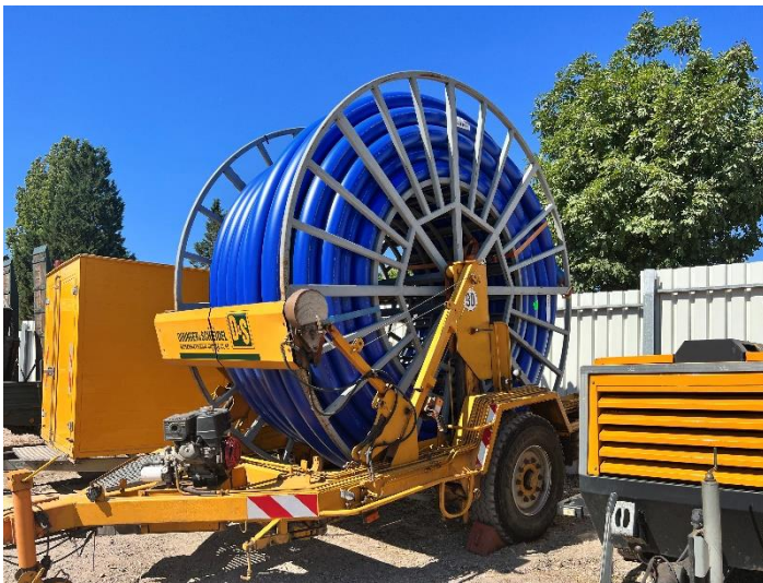
Compact Pipe-Verfahren: Das im Werk produzierte, c-förmig vorverformte HDPE-Rohr wird auf die Baustelle transportiert, in die Altröhrlleitung eingezogen und close-fit rückverformt
