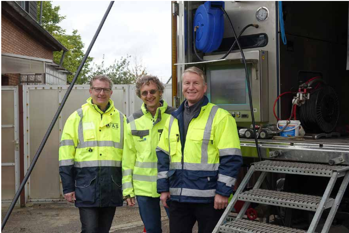
Zufriedene Beteiligte nach erfolgreicher Sanierung (v.l.n.r.): Dipl.-Ing. Carsten Bolz, ITAS Salzgitter GmbH, Dipl.-Ing. Lutz Halfen, Stadtwerke Erfstadt und Bauleiter Eugen Bogoslavski, DIRINGER & SCHEIDEL ROHRSANIERUNG GmbH & Co. KG, NL Rhein-Ruhr.
